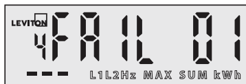
Pantalla de error que muestra un código de falla, servicio de fábrica requerido
