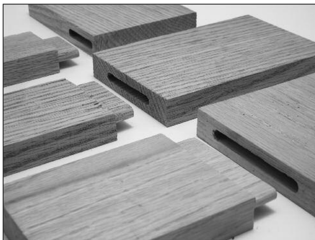
Exemples d'assemblages à mortaise et tenon
