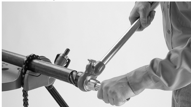
Figure 4 – Escariado del extremo del tubo
