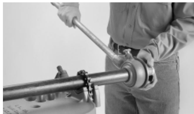
Figure 3 – Montage de la fileteuse sur le tuyau
