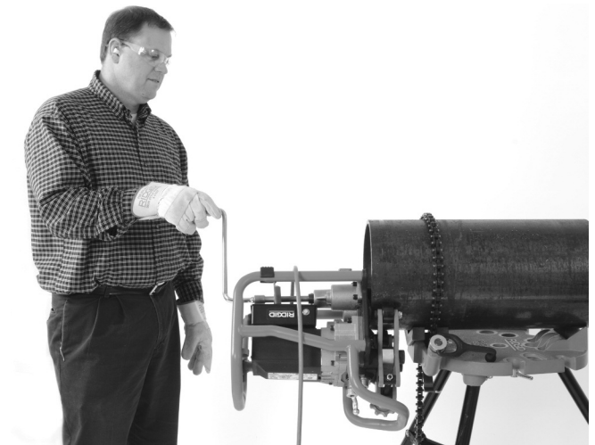
Figure 20B – Biseautage en cours (pièce fixe/machine mobile)
