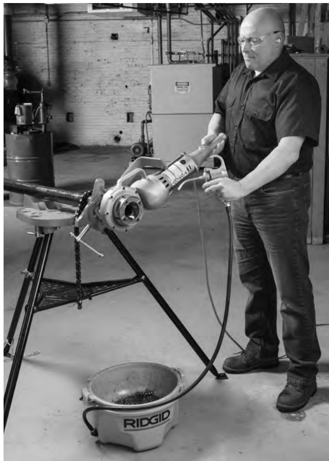
Figure 9 – Filetage des tuyaux
