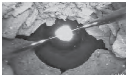
Figure 13 – Forage transversal typique dans conduite d'évacuation
