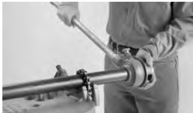
Figure 3 – Montage de la fileteuse sur le tuyau
