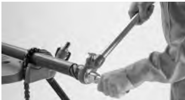
Figure 2 – Alésage de l'extrémité du tuyau
