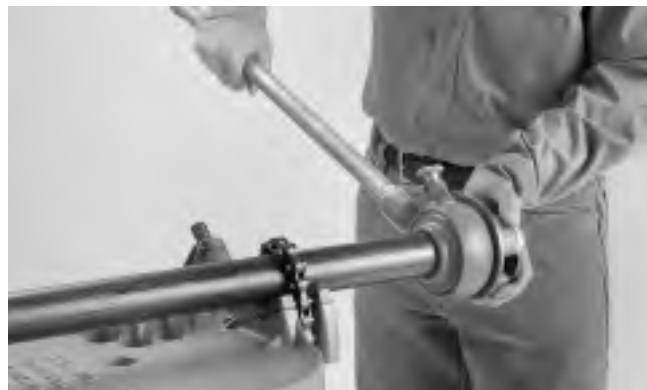
Figure 3 – Montage de la fileteuse sur le tuyau
