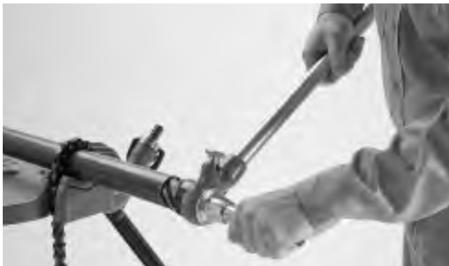
Figura 2 – Escariado del extremo del tubo
